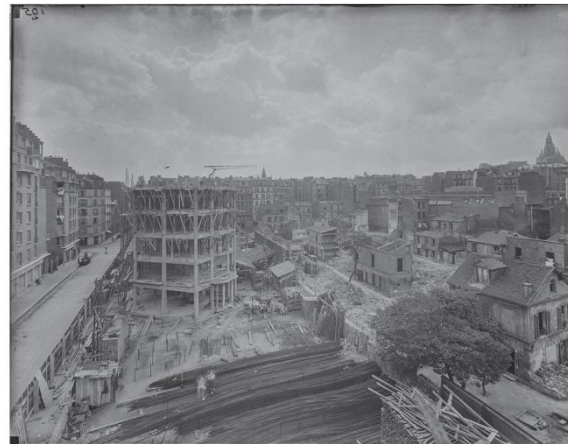
Groupe Letort, Ensemble d'habitations à bon marché en cours de construction à l'emplacement d'un îlot insalubre, vers 1929. Plaque de verre. Paris, coll. Paris Habitat
